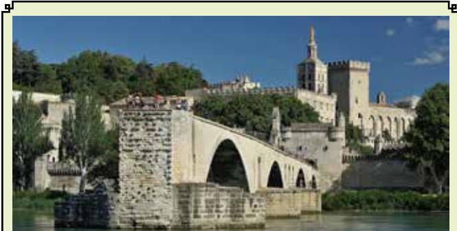
AVIGNONE - Ponte di San Benezèt
